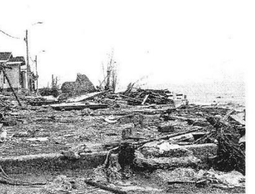
破壊された海岸沿いの集落トウネス
