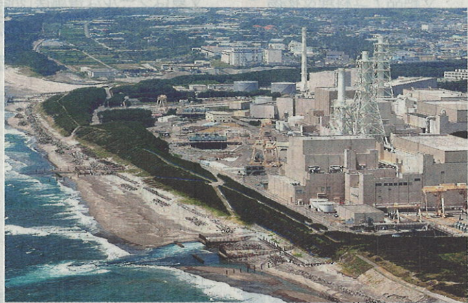
海岸線に高さ18mの防波壁を建設する予定の中部電力浜岡原発。砂丘は植栽され、緑の壁となっている。静岡県御前崎市で、本社へ「まなづる」から
