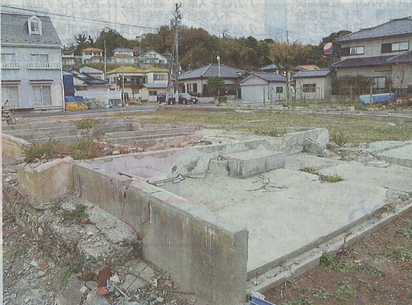
津波で流された家屋の基礎部分が今なお残る大津地区。周囲には再建された家屋が建ち並び、北茨城市大津町で11月28日、土江洋範撮影
