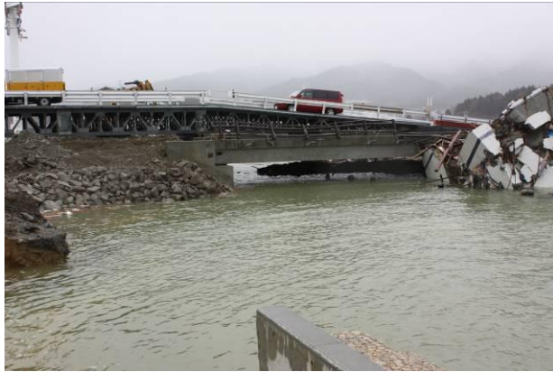
図7. 流失を免れた川原川橋（道路橋）
