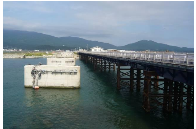
図 5. 気仙大橋の仮復旧の様子（左 2011 年 4 月，右 2011 年 9 月）
