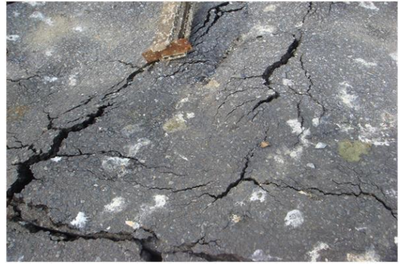
図4. 液状化被害の一例
