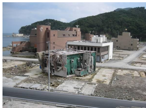
図 7 津波により横転した鉄筋コンクリート構造物
