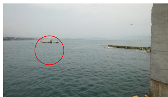
図-3.2 波路上漁港の防波堤
