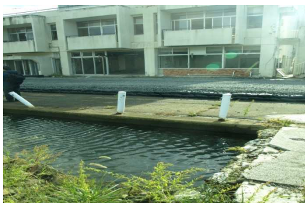
図3 盛り土された道路と事務所跡
