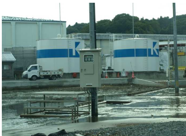
図6 船舶用燃料タンク
