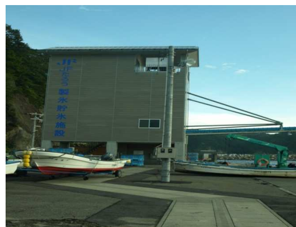
図7 新設された製氷施設
