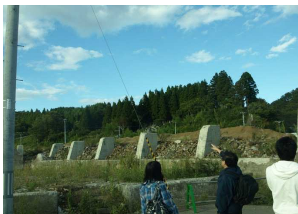
図4 破壊された防潮堤の跡
