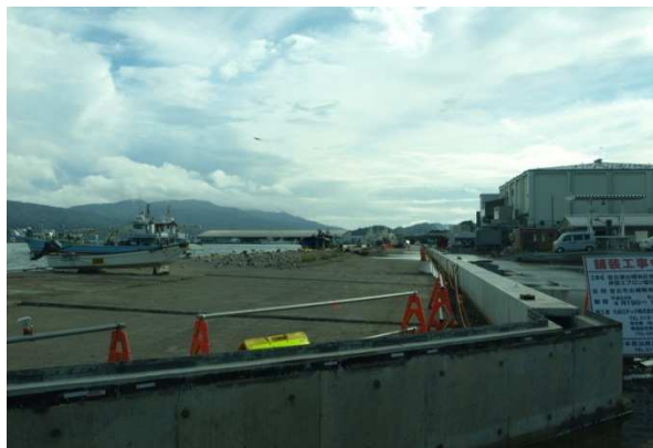
図2 浸水を防ぐための防潮堤
