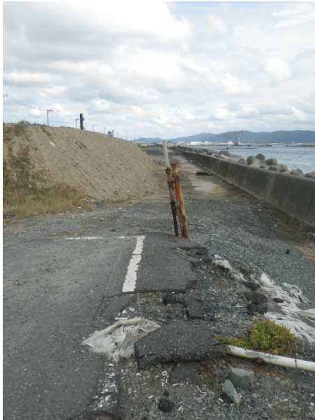
写真11 工場前に設置された盛土
