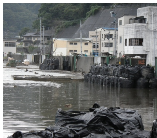
写真2 機能を失った水門に積まれた土嚢
