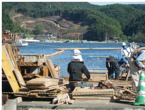
写真7 工事現場に設けられたオイルフェンス
