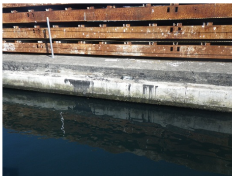
写真6 黒ずんだ海水と壁面に付着した重油
