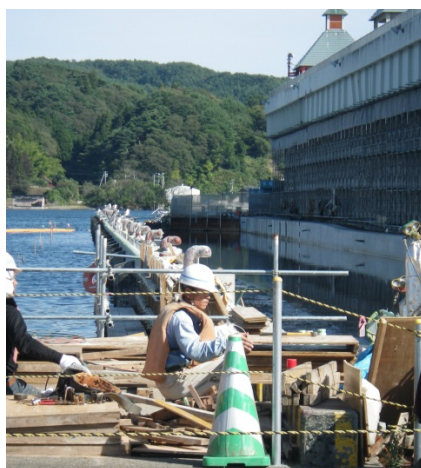
写真8 気仙沼市魚市場の復旧工事
