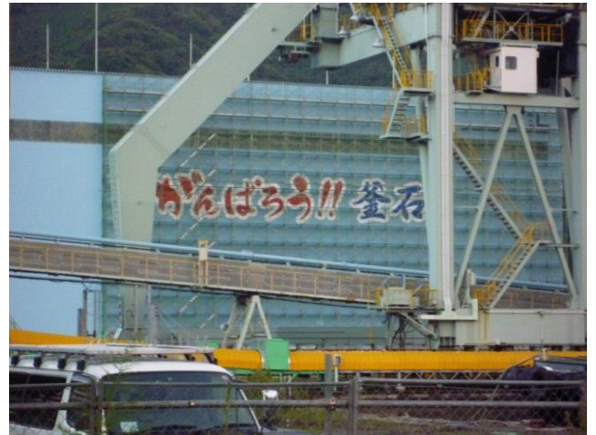
写真4 再建中の工場の様子
