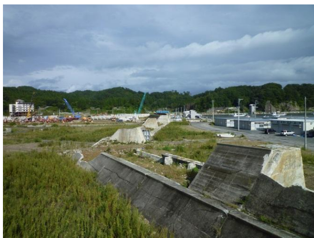
写真 1 防潮堤の被害様子
