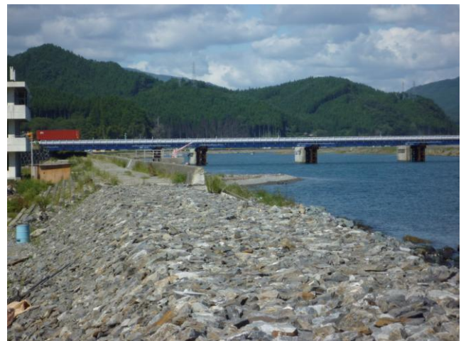
写真6 気仙川沿いの復旧状況
