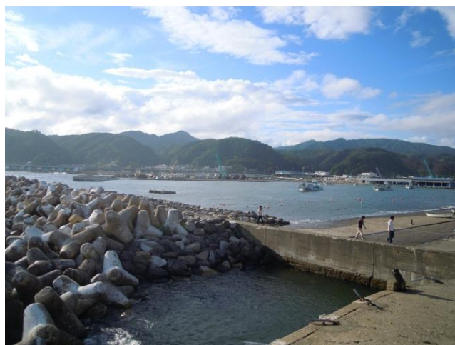
写真 2 復興中の港湾施設
