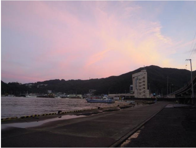
写真3 地盤沈下の影響が見られる釜石港
