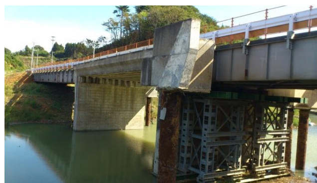
写真-3 二十一浜橋の復旧状況
