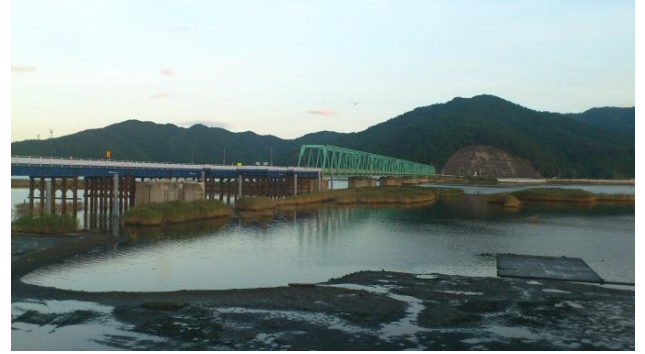
写真-5 現在の新北上大橋
