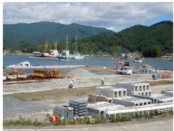
図5 盛り土による港の本工事的復旧 (大船渡市)
