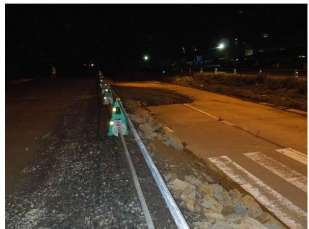
図4 応急的な盛り土による道路の復旧 (石巻市)
