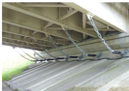
図2 落橋防止装置
