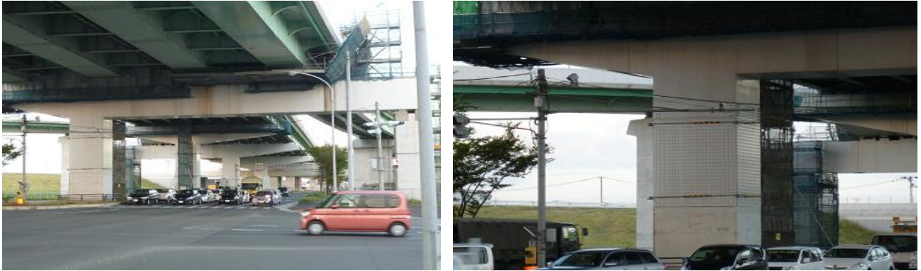
図 15 復旧工事が進んでいる現状
