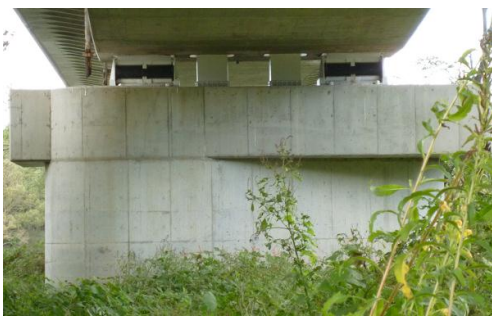
図3 江刺市寄り橋脚（損傷なし）
