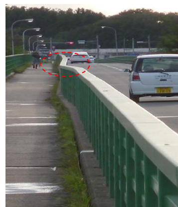
図7 高欄の変形
