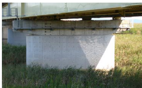
図 14 耐震補強済みの橋脚
