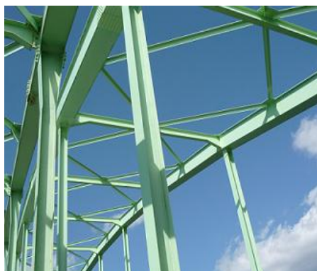
図 8 復旧されたトラス
