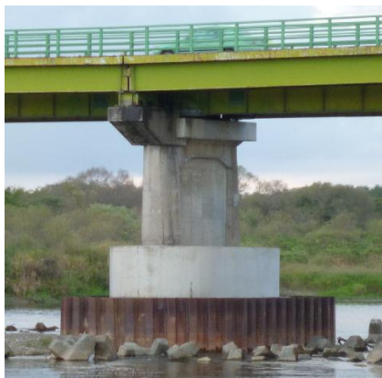
図6 傾斜橋脚の補強状況
