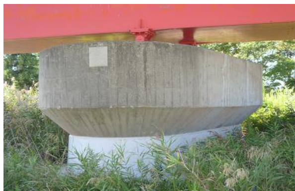
図 12 耐震補強済みの橋脚
