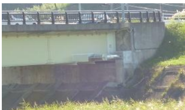
図 13 復旧済みのダンパー取付け部
