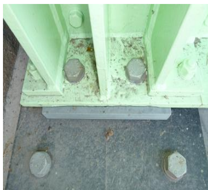
図 9 復旧された支承
