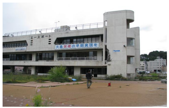
写真-4 気仙沼港の津波被害状況
