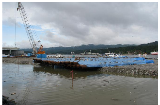
写真-2 矢板式岸壁の復旧作業
