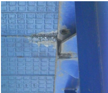
写真1 漏水の様子
