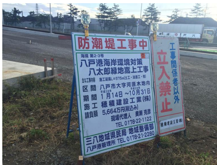
図-10 防潮堤工事の様子
