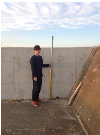
図-18 石巻新規防潮堤
