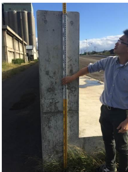
図-9 2m 防潮堤
