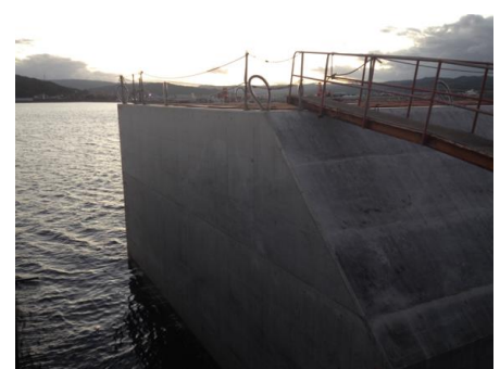
図-13 ケーソン工事
