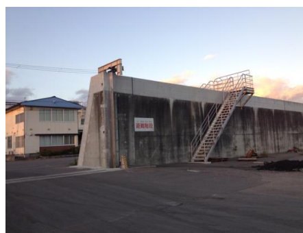
図-12 久慈港付近防潮堤
