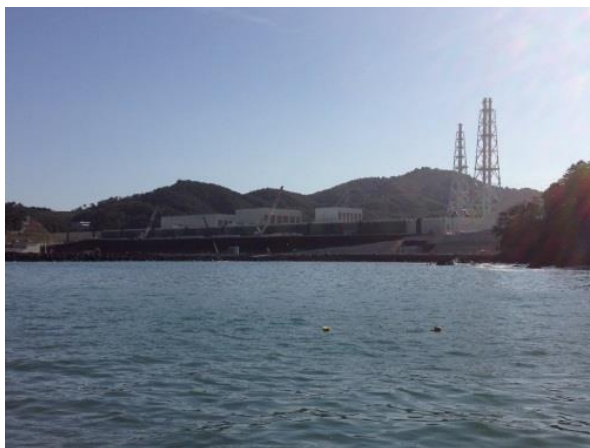
図-15 女川原子力発電所
