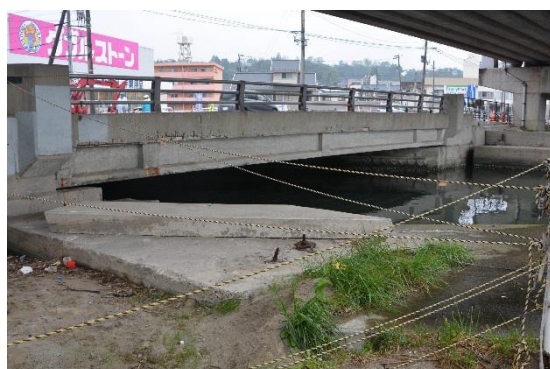
図-4.水門の復旧状況
