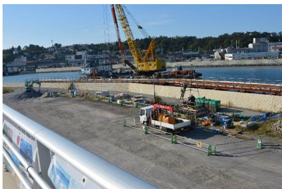
図-3.防潮堤の復旧状況
