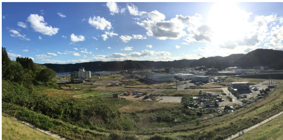
写真-3 高台からの景観 (田老町)
