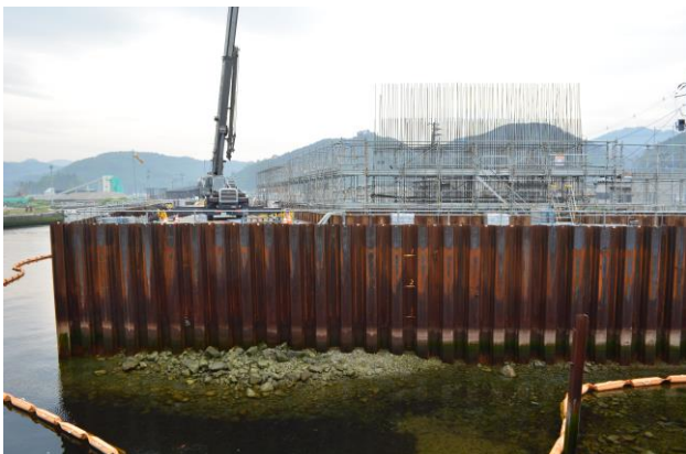
写真-1 防潮堤 (5月時点)
