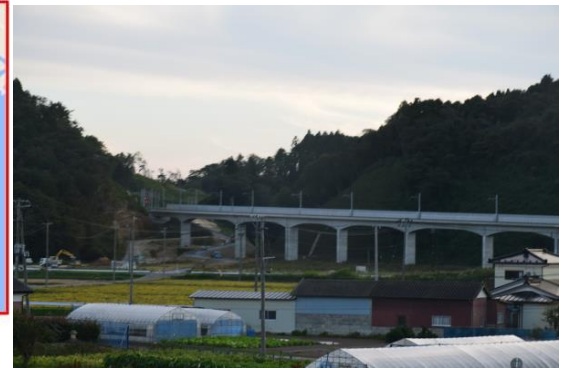
図 1.8 駅の移転に伴い建設された高架橋
