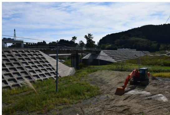
図 1.4 修復された泊築堤
