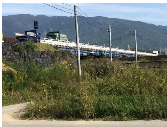
写真-3 気仙大橋
