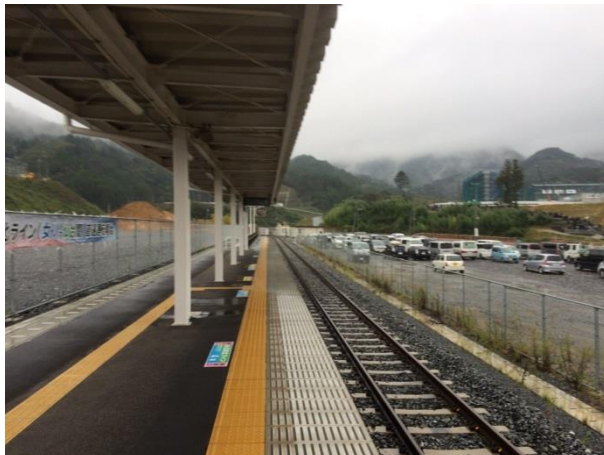
写真－7 女川駅ホーム
