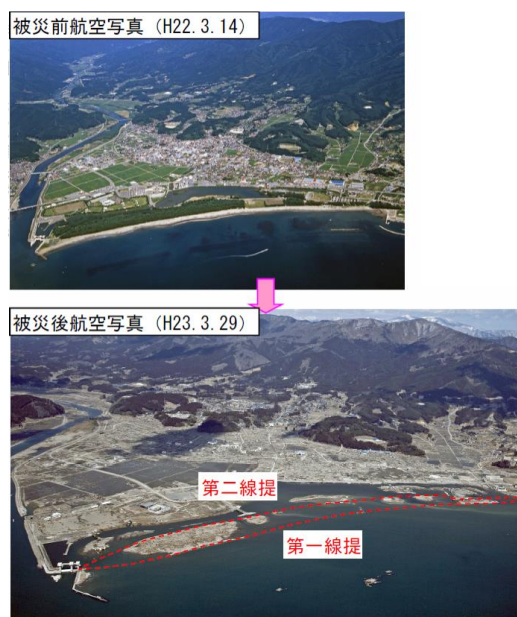
図 1. 高田地区被災状況
