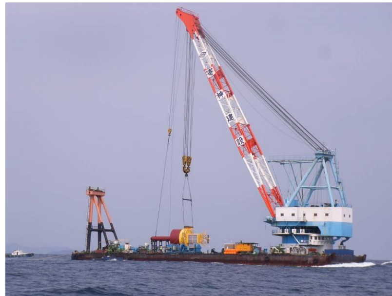
台船積込状況
